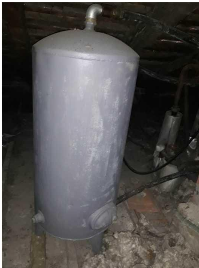
Слика – Привремена (половна) експанзиона посуда запремине V=300 lit
