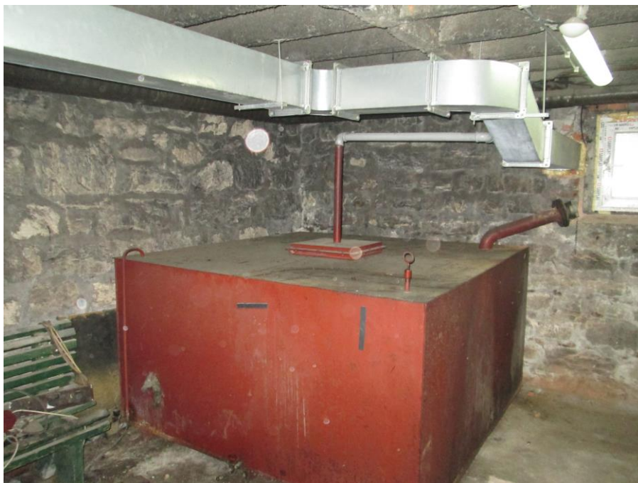
Слика 2. Резервоар за складиштење лож уља
