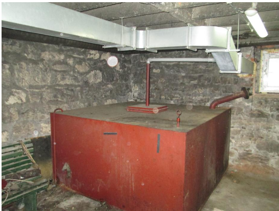
Слика 2. Резервоар за складиштење лож уља
