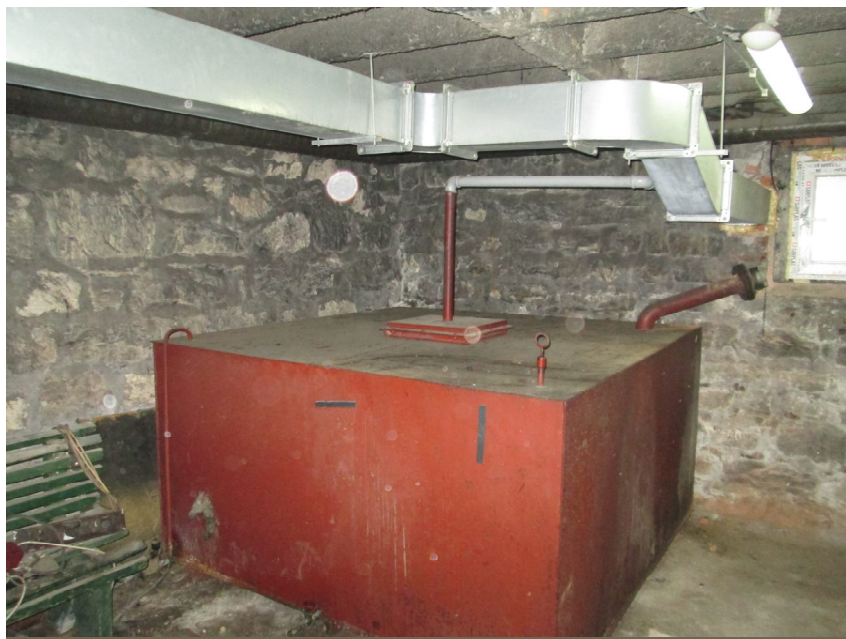
Слика 2. Резервоар за складиштење лож уља
