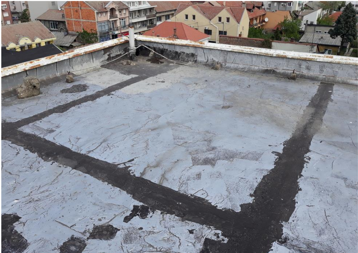
Слика 1 Завршно заштитни слој хидроизолације од кровопласта беле боје
