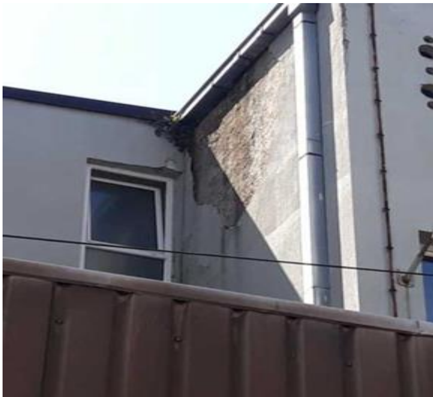
Fotografija 3: Deo fasade koji je predviđen za sanaciju
