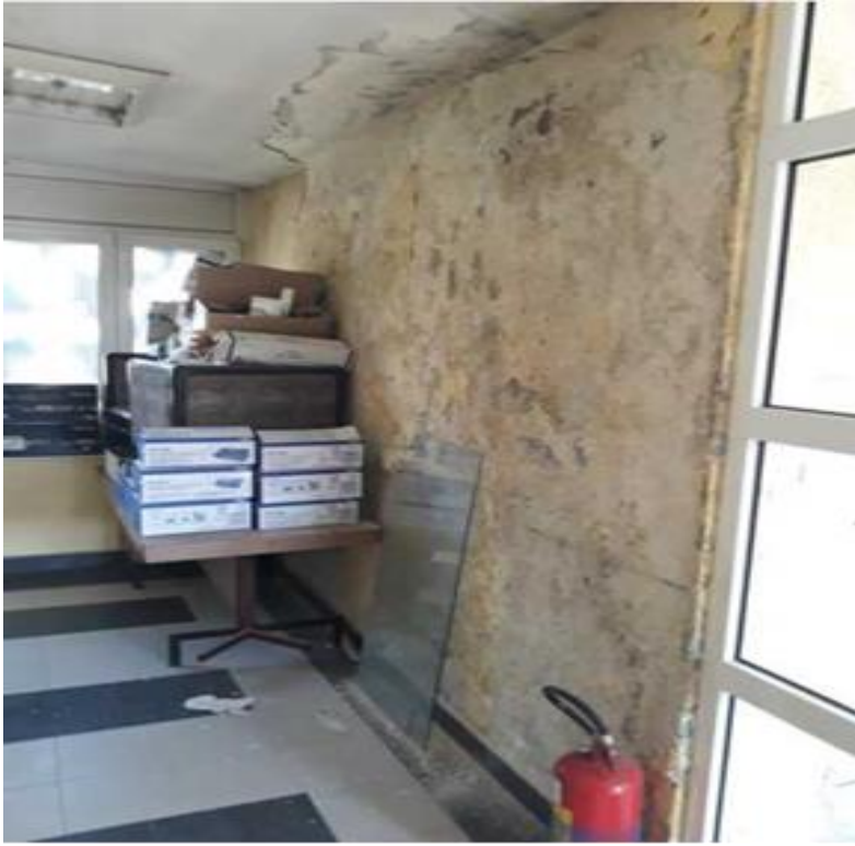
Fotografija 5: Deo zida u unutrašnjosti objekta koji je predviđen za sanaciju
