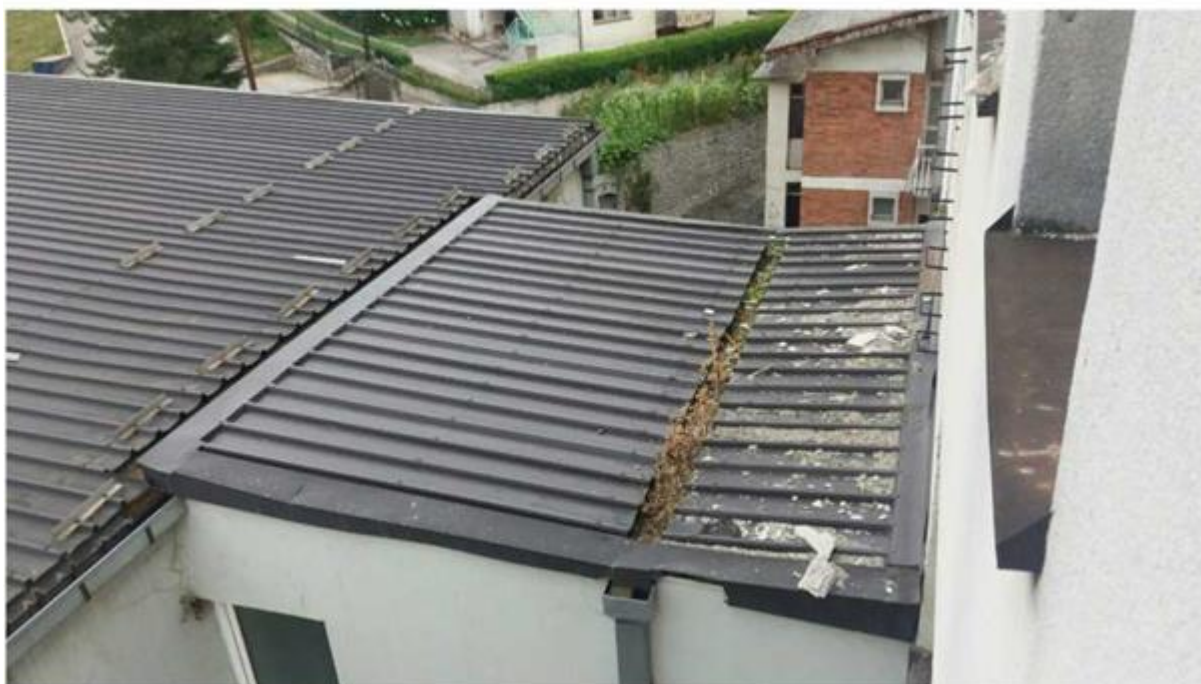
Fotografija 2: Izgled krovnog pokrivača iznad stepeništa
