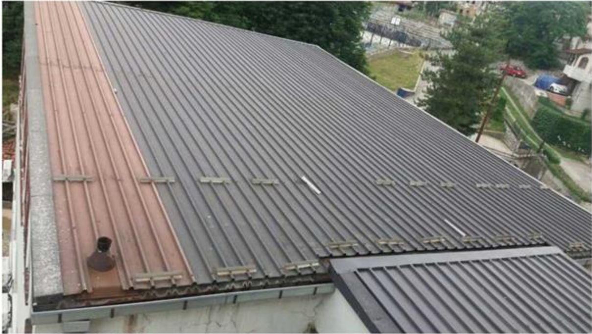
Fotografija 1: Izgled krovnog pokrivača
