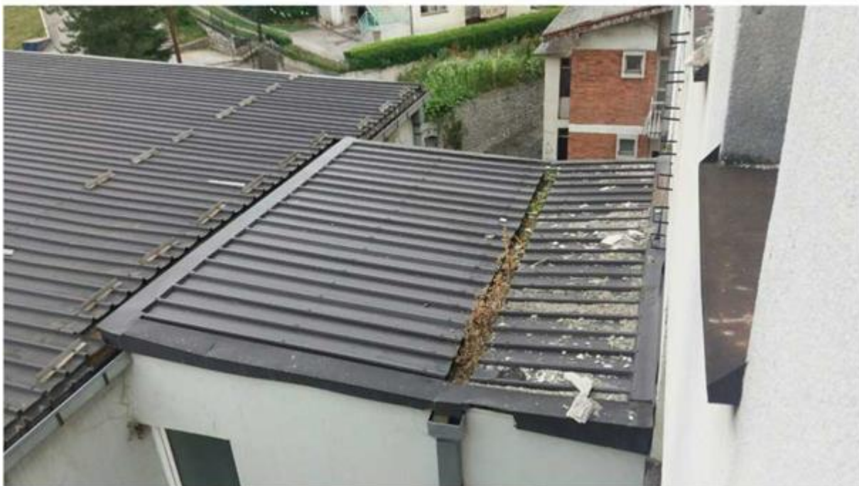
Fotografija 2: Izgled krovnog pokrivača iznad stepeništa
