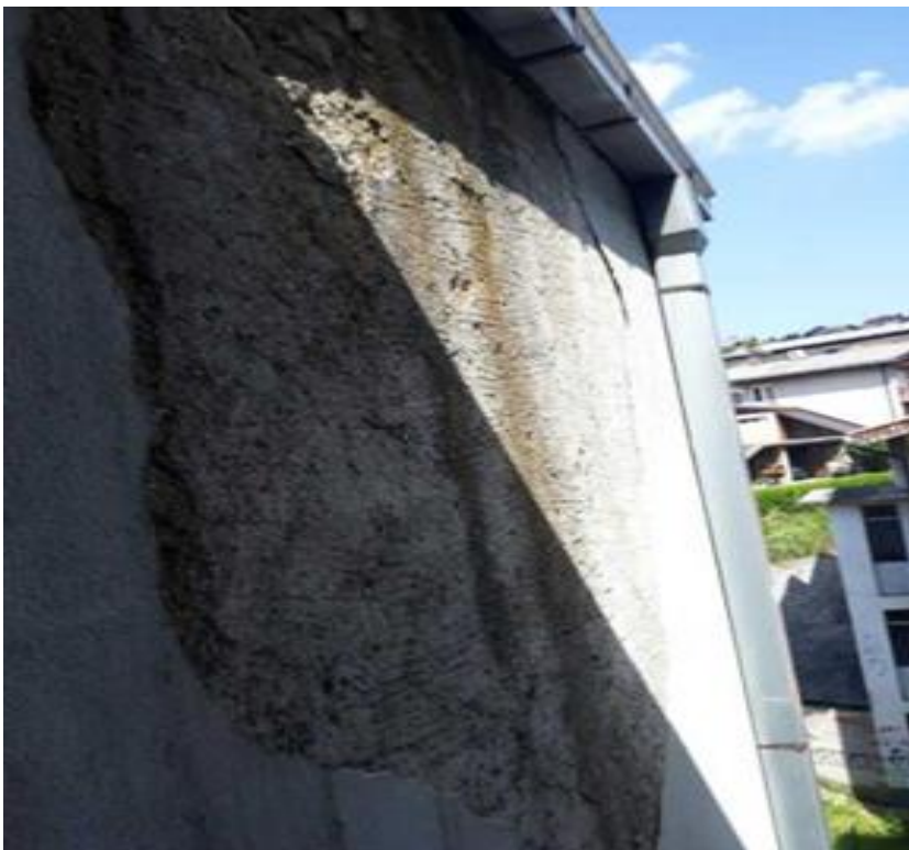
Fotografija 4: Deo fasade koji je predviđen za sanaciju
